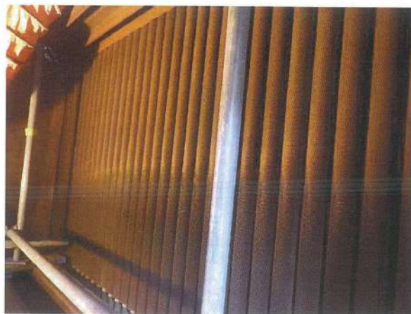
รูปด้านซ้ายมือไฟของหม้อน้ำ
