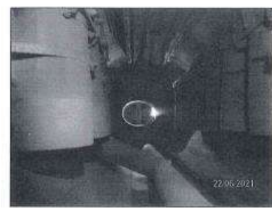
ภาพถ่ายแบบเป็น Steam Drum ของหม้อไอน้ำ แสดงน้ำที่เต็มในหม้อไอน้ำ
